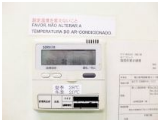
写真 2：エアコンのコントローラ
